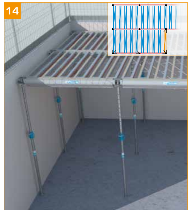
- Die Rahmen C2+ oder C4+ mithilfe der TopPerche-Stange nach und nach weiter verlegen.
