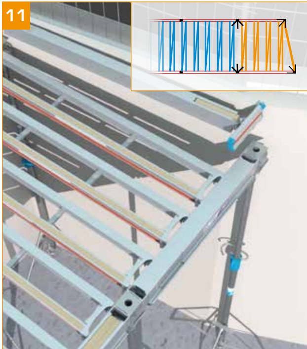
- Den Nebenträger für Verlegung im Winkel anbringen.
